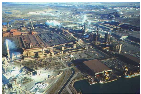
L'aciérie de Fos (photo Arcelor)
